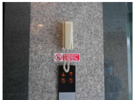
โทรศัพท์ฉุกเฉิน และป้ายเตือนห้ามใช้ลิฟต์ ขณะเกิดเพลิงไหม้
